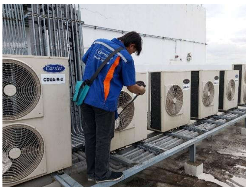
รูปที่ 45 เจ้าหน้าที่ล้างเครื่องปรับอากาศ
