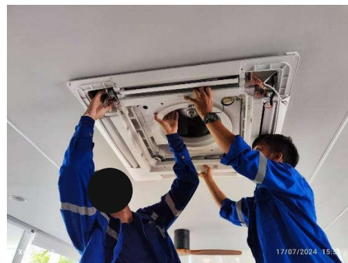
รูปที่ 45 เจ้าหน้าที่ล้างเครื่องปรับอากาศ
